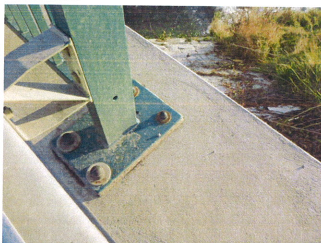
korozí kotevnic prvku
